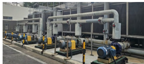
제2공장 쿨링타워 인버터 설치
